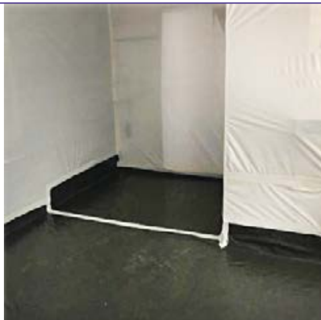
Exemple de mise en œuvre d'un cuvelage
