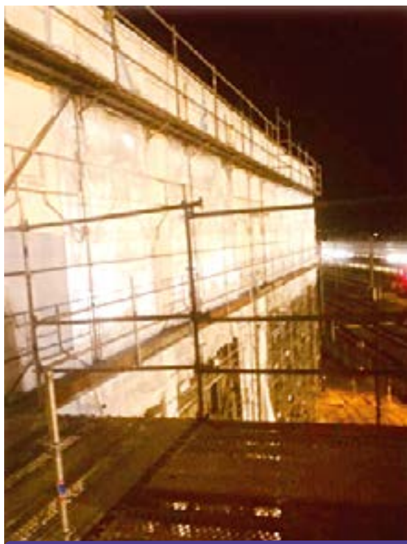
Exemple de mise en oeuvre d'un isolement de la zone de travail
